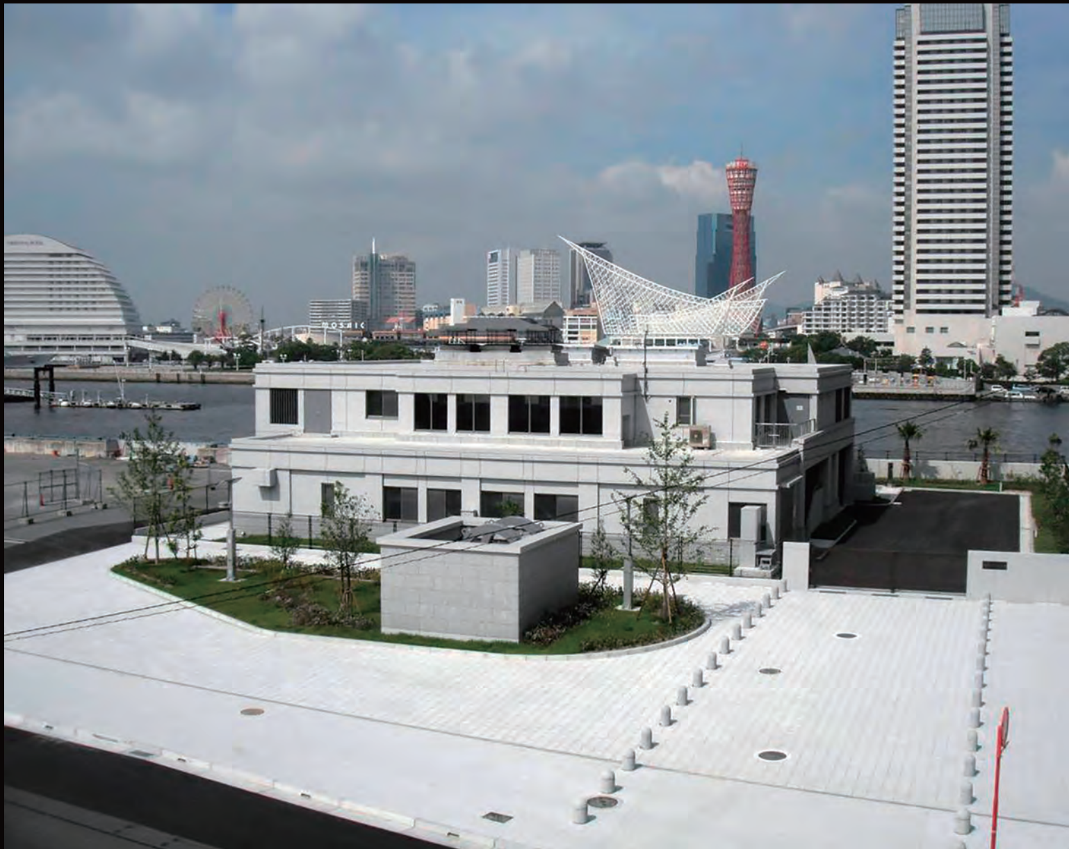
下水道光ファイバーを活用して遠隔で運転管理されている京橋ポンプ場（神戸市）
