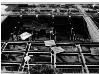
機能停止した東灘処理場
