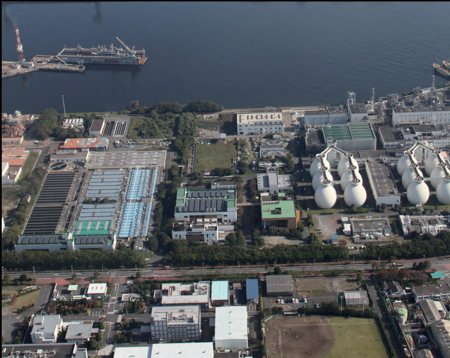
ネットワーク送水で下水道光ファイバーを活用する北部第二水再生センター（横浜市）
