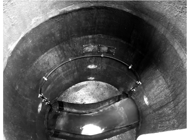
写真5 実証試験の状況
