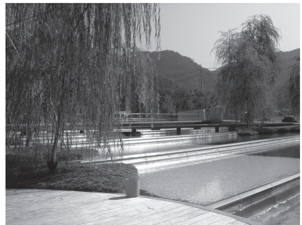
写真1 新見浄化センターカスケード
